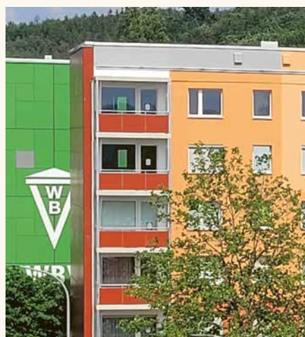
Die neuen Balkone sind optisch ansprechend und größer als die Vorgänger.
