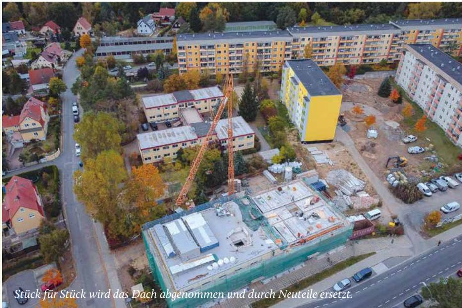
*Stück für Stück wird das Dach abgenommen und durch Neuteile ersetzt.*
