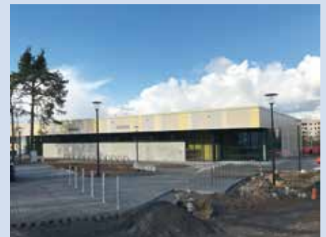
Die Bauarbeiten rund um die neue Sporthalle sollen Ende 2020 fertiggestellt sein.
