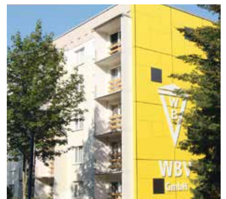
Momentaufnahme der Baumaßnahmen
